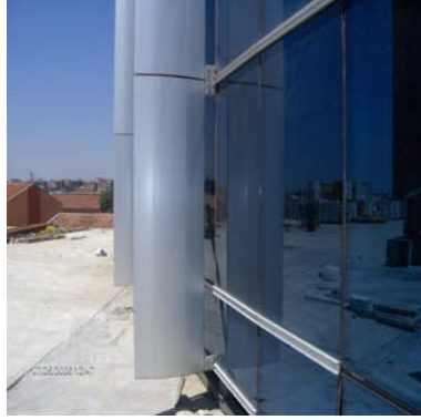
Resim 1.5: Baskı ıtası ile tutturulmuş cam kaplama sistemi
