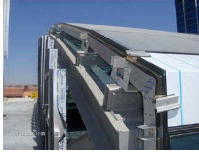
Resim 2.12: Sızdırmazlık elemanlarının montajı yapılmış çatı detayı
