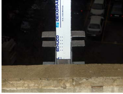
Resim 1. 59: Düşey profillerde yatay profiller için monte edilen takozlar
