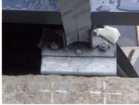
Resim 1. 47: Parapet duvara koordinatlar taşınarak yapılan ankraj
