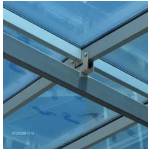
Resim 2.24: Isıcam panel kaplama sisteminin alttan görüntüsü
