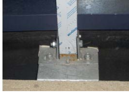
Resim 1. 60: Yatay profillerin düşey profillerde monte edilen takozlara yerleştirilerek montajının yapılması
