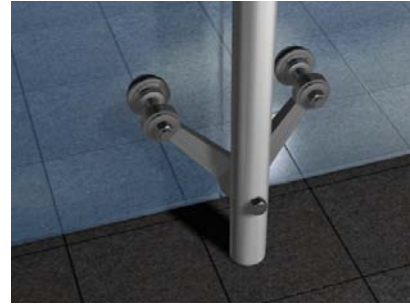
Resim 1. 27:Transparan cephe sisteminde kullanılan iki yönlü bağlantı elemanı
