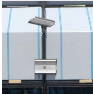
Resim 2.25: Panellerin çıtalarla geçici olarak tutturulması
