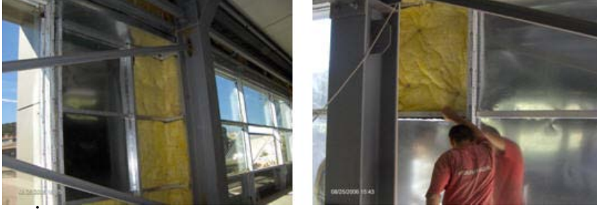
Resim 2.18: İç cepheden cam yünü veya taş yünü ile yalıtım yapılması ve alüminyum levhayla kaplanması
