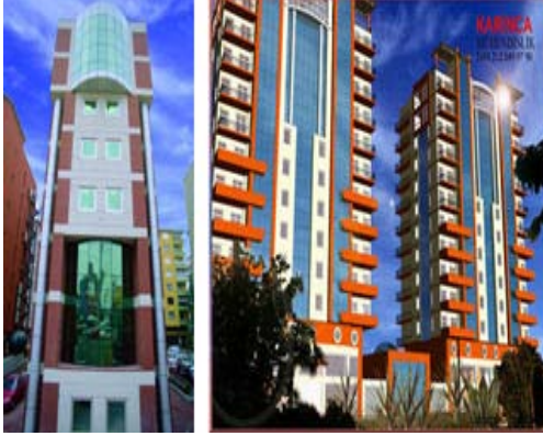
Resim 1.34 :Alüminyum kompozit panel cephe sistemi ile yapılmış bina örnekleri
