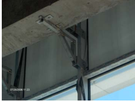
Resim 1. 49: Kiriş alttan montajı yapılan ankraj
