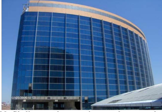
Resim 2.26: Giydirme cephe montajı tamamlanmış cephe görünüşü
