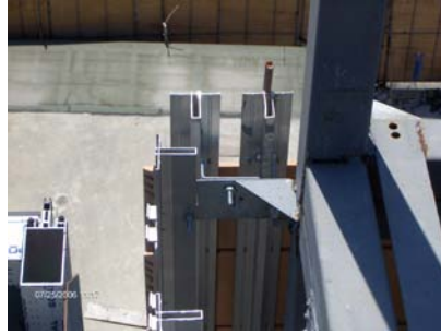
Resim 1. 64: Montajı tamamlanmış kaplamanın köşe detayı
