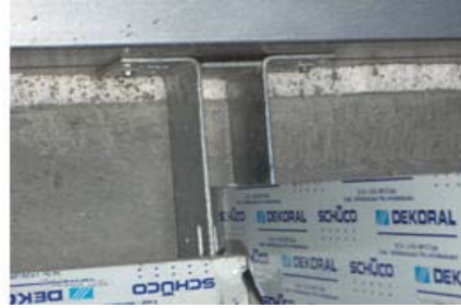
Resim 1. 65: Montajı tamamlanmış kaplamanın üstten görünüş detayı
