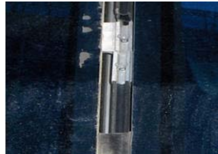
Resim 2.8: Sızdırmazlık fitilleri, tutucu parçalar ve kauçuğu yapıştırılmış görüntü ve detayı
