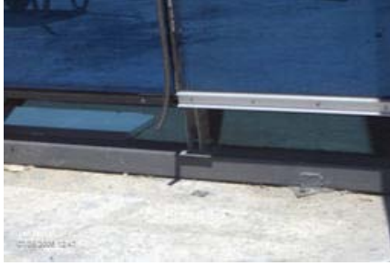
Resim 2.6: Sızdırmazlık fitilleri montajı yapılmış cephe detayı
