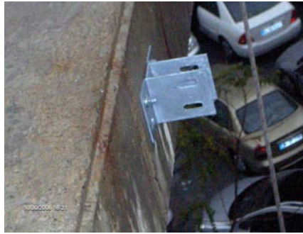
Resim 1. 45: Betonarme yüzeye sabitlenen ankraj
