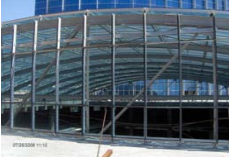
Resim 1.61: Düşey ve yatay profilleri döşenmiş cepheler
