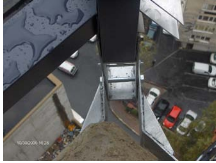
Resim 1. 46: Betonarme yüzeye sabitlenen köşe ankraj
