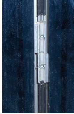
Resim 2.14: Kaplama tutucu elemanların montajı
