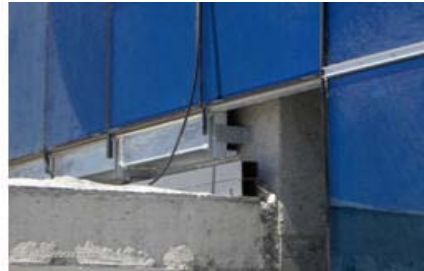
Resim 1. 66: Montajı tamamlanmış ve tamamlanmamış cephe görünüşleri
