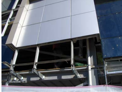
Resim 2.19:Montajı yapılmış kompozit ve cam panellerin dış cephede görünüşü
