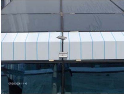
Resim 2.23: Eğimli çatıda cam ve kompozit kaplama birleşimi
