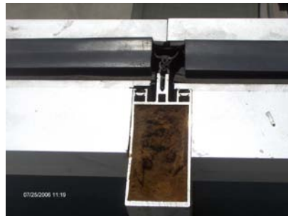
Resim 2.9: Sızdırmazlık fitilleri birleşim detayı
