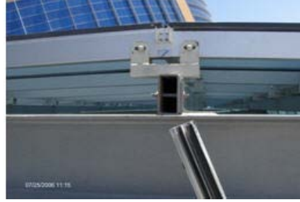
Resim 2.6: Sızdırmazlık fitilleri montajı yapılmış cephe detayı
