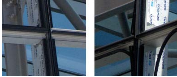
Resim 1. 77: Sızdırmazlık fitillerinin montajı
