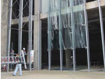
Resim 1.55: Düşey profilleri ankrajlara montajı tamamlanan cephe bağlantı detayı
