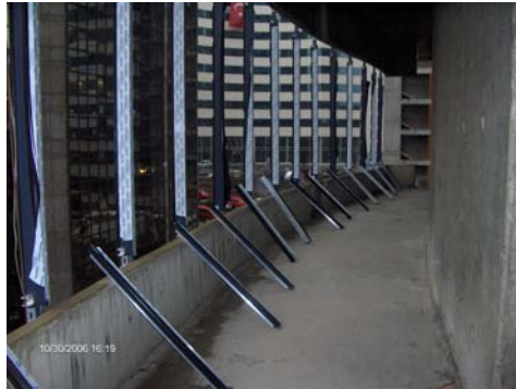
Resim 1. 58: Yatay profillerin düşey profillere montaj hazırlığı
