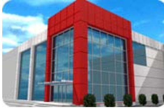
Resim 1.1: Giydirme cephe sistemi ile yapılmış bina cephe görünüşü
