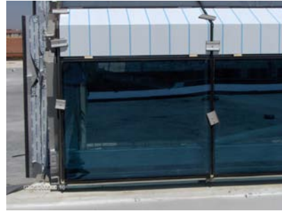
Resim 2.23: Eğimli çatıda cam ve kompozit kaplama birleşimi
