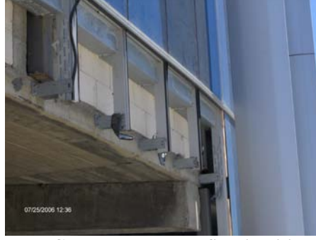
Resim 1. 56: Cephede düşey profillerin bitiş noktaları
