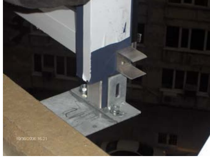
Resim 1. 43: Ankrajları parapet duvara montajı yapılan bina cephesi
