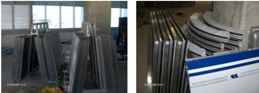
Resim 2. 7: Atölyelerden şantiye sahasına getirilerek istiflenmiş kaplama malzemesi ısıcamlar ve kompozit paneller
