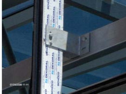
Resim 1.55: Düşey profilleri ankrajlara montajı tamamlanan cephe bağlantı detayı
