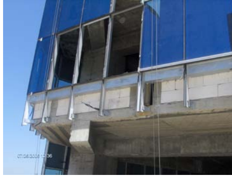
Resim 1. 57: Katlar arası sızdırmazlık profili görünüşü
