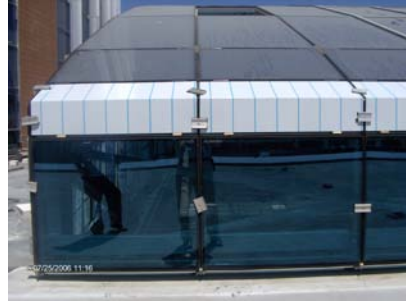
Resim 2.22: Eğimli çatı görünüşü
