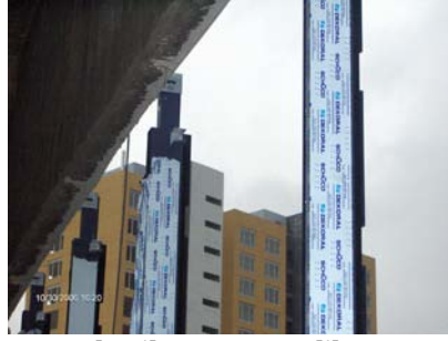
Resim 1.53: Ankrajlara monte edilen düşey profiller
