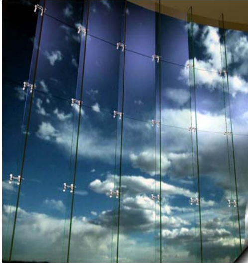
Resim 1. 32: Transparan cephe görünüşü
