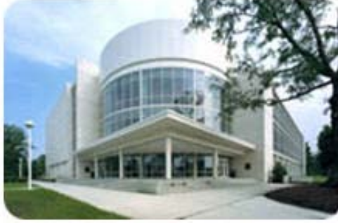
Resim 1. 2: Giydirme cephe sistemi ile yapılmış bina cephe görünüşü
