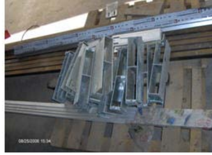
Resim 1. 40: Projeye göre hazırlanmış ankraj çeşitleri
