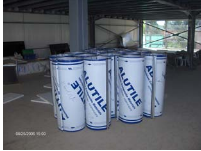
Resim 2.2: Şantiye sahasında istiflenmiş kaplama malzemesi kompozit paneller
