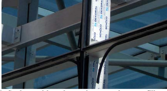
Resim 1.80: Sızdırmazlık malzemesi yapıştırılmış profiller ve detayları
