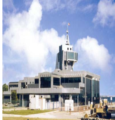
Resim 1.35 :Alüminyum kompozit panel cephe sistemi ile yapılmış bina örnekleri
