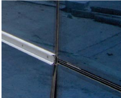
Resim 2.13: Kaplama tutucu ıtası yapılmış cephe görüntüsü
