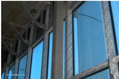
Resim 1.62 Kiriş altına sabitlenmiş ankrajlar, montajı tamamlanmış profiller
