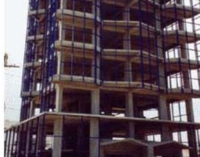
Resim 1.61: Düşey ve yatay profilleri döşenmiş cepheler
