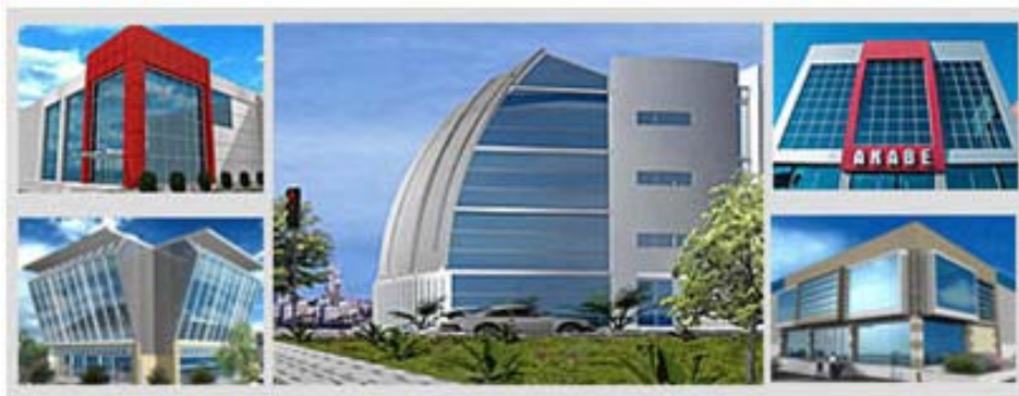
Resim 1.33: Kompozit panel cephe sistemi ile yapılmış bina örnekleri
