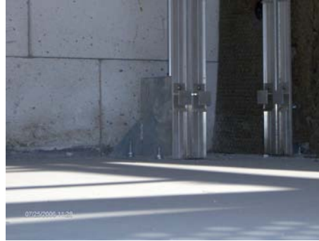
Resim 1.48: Döşemeye montajı yapılan ankraj montajı
