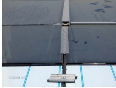
Resim 2.11: Sızdırmazlık fitilleri, parçaları ve ıtası monte edilmiş görüntüsü
