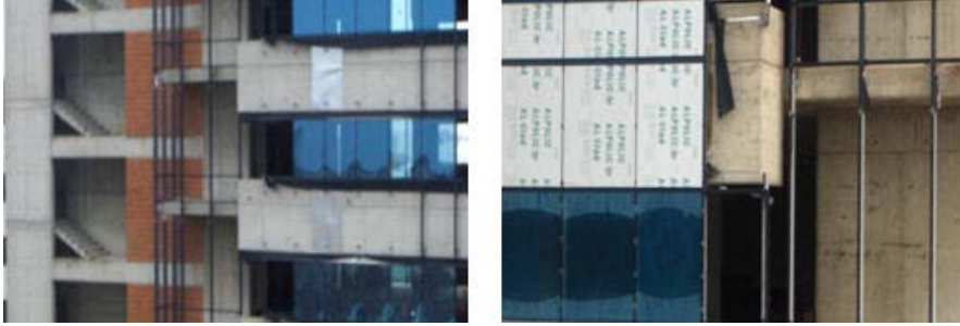
Resim 1.44: Ankraj montaj tamamlanan ve devam eden farklı cephe görüşleri
