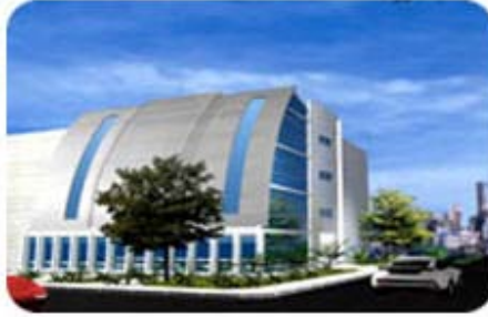
Resim 1.3: Giydirme cephe sistemi ile yapılmış bina cephe görünüşü
