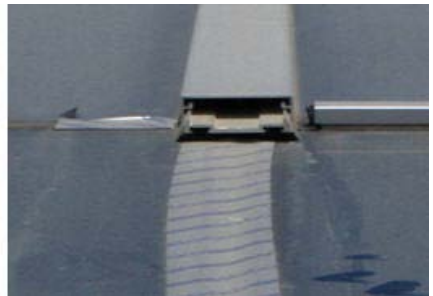
Resim 2.7: Sızdırmazlık fitilleri, parçaları ve çıtası monte edilmiş görüntü detayı
