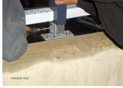
Resim 1. 52: Profillerin, ankrajlara çelik civata ve vidalarla monte edilmesi
