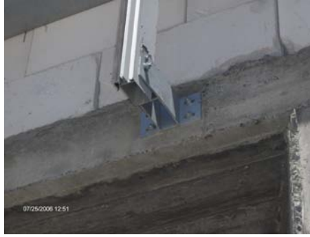
Resim 1. 50: Kiriş önden montajı yapılan ankraj
