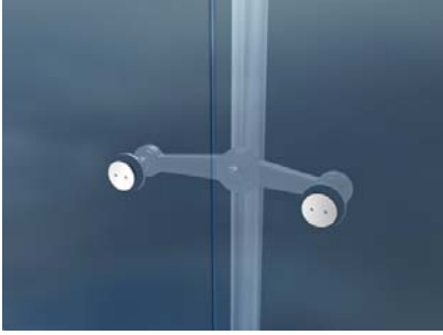
Resim 1. 24 :Transparan cephe sisteminde kullanılan iki yönlü bağlantı elemanı
