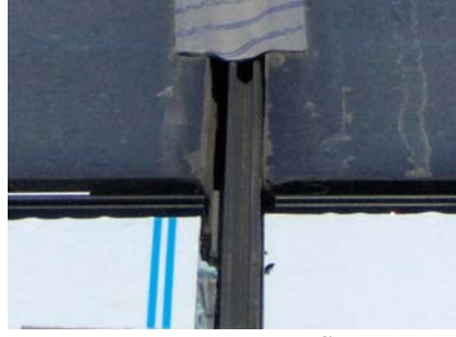
Resim 2.10: Yalıtım bandı ve profil yapıştırma detayı
