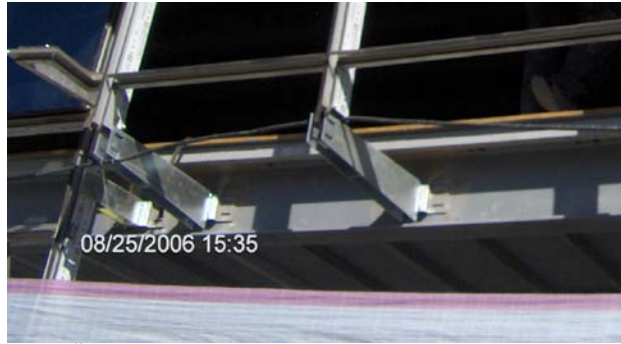
Resim 1. 51: Ön cephede çelik kiriş kaynakla yapılan ankraj montajı
