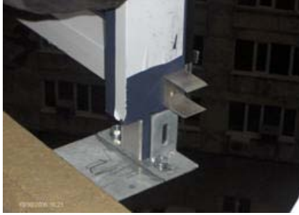
Resim 1. 60: Yatay profillerin düşey profillerde monte edilen takozlara yerleştirilerek montajının yapılması
