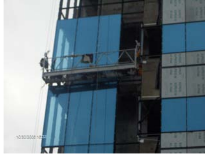
Resim 1. 36: Yatayda ve düşeyde hareket edebilen asma iskele
